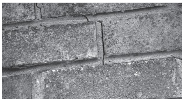
شکل ۳-۳- نمای نزدیک از یک ترک انبساطی با جابه‌جایی افقی ۱ تا ۲ میلی‌متر
